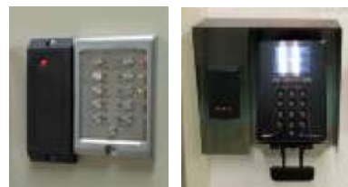
ICカード・暗証番号キー 静脈認証、入退出チェック
